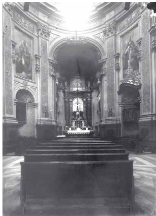
Abb 4: Dreifaltigkeitskirche Salzburg vor der Restaurierung 1947 © BDA, Bildarchiv Landeskonservatorat für Salzburg
